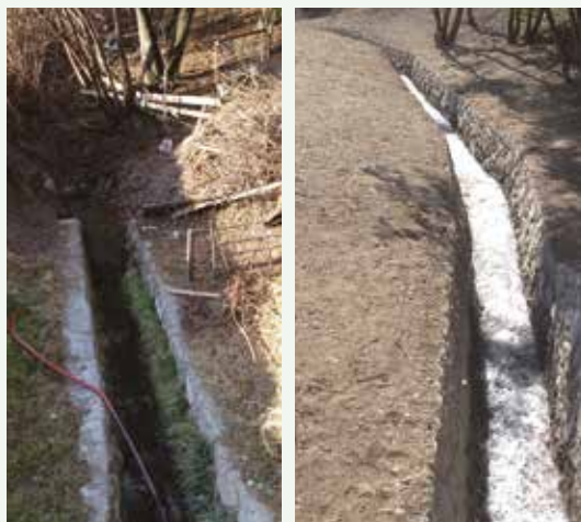
Prima e dopo la sistemazione a Cort
