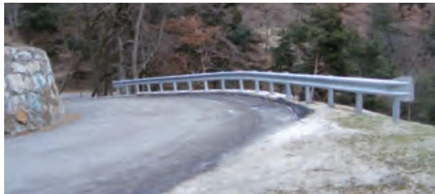
Sistemazione frana in località Vacourneille
