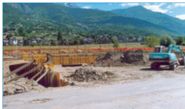
Lavori del campo sportivo.
