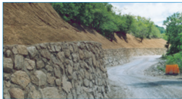
Lavori alluvione - sistemazione Veynes-Cretallaz.
