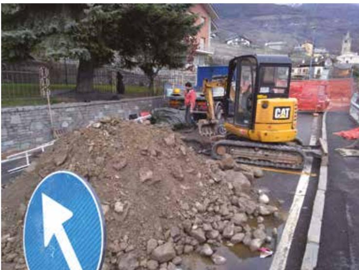
A causa della perdita consistente di acqua da una presa del **Canale Baudin**, interrato sotto la strada comunale in Loc. Meysattaz, che poteva compromettere la stabilità del muro sotto ripa, si è intervenuti rifacendo completamente la presa e ripristinando il suo corretto funzionamento.
